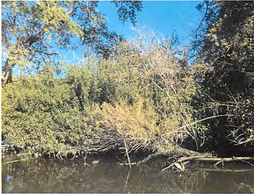
1640 W. S. Tuxedo Ave.: Dense brush overhanging Smith Canal.
